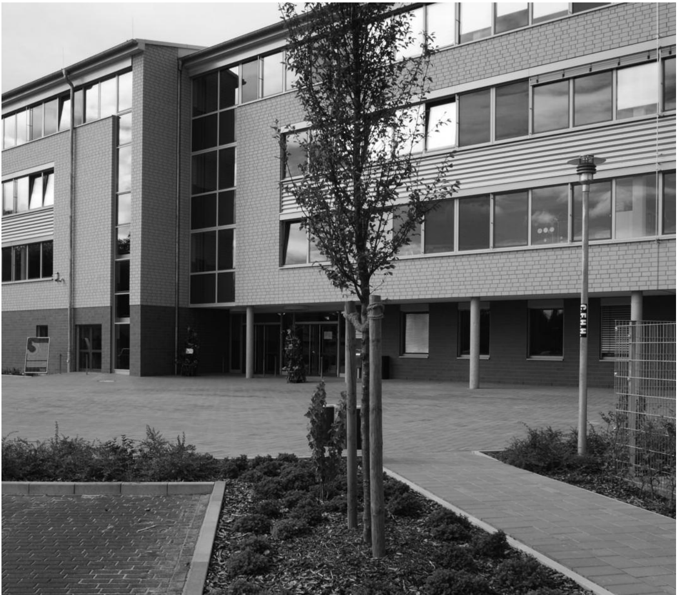
Der Haupteingang markiert durch den Gebäudeversatz
